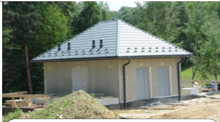
Budowa oczyszczalni w m. Kunów 3.668.647,94 zł
