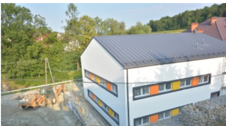
Budowa przedszkola w Paszynie 2 500 000 zł
