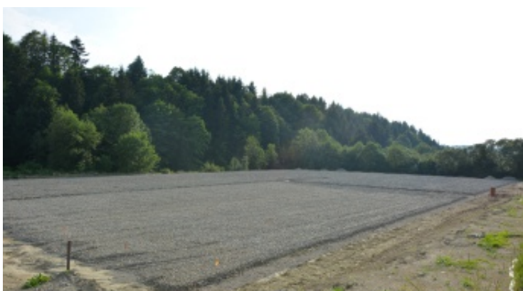
Remont Boiska sportowego w Paszynie 2.275.500 zł
