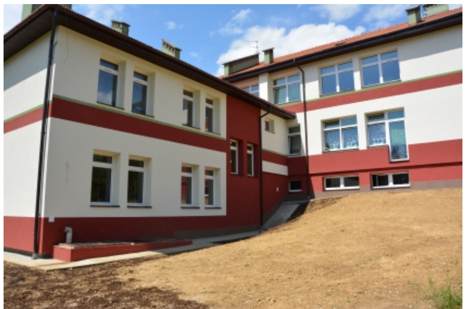
Szkoła w Januszowej po termomodernizacji
