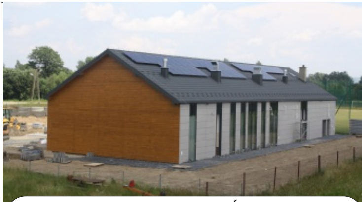
Budowa Centrum Aktywności Świniarsko 3.321.000,00 zł
