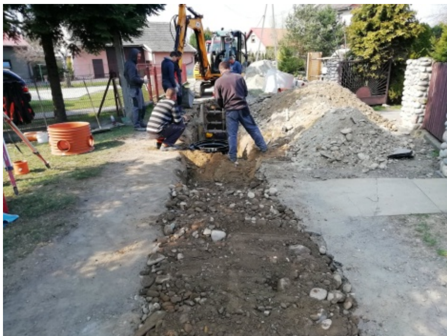
Przebudowa kanalizacji w Świniarsku
