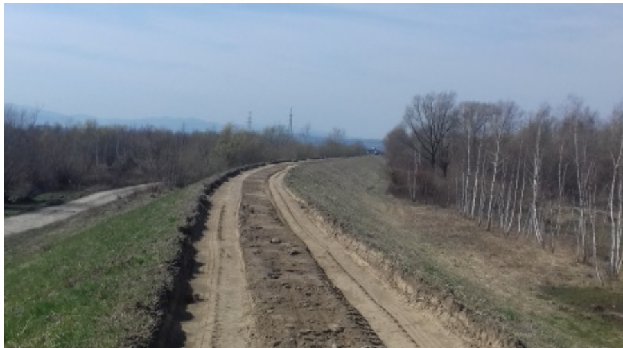
Budowa nowej ścieżki rekreacyjnej
