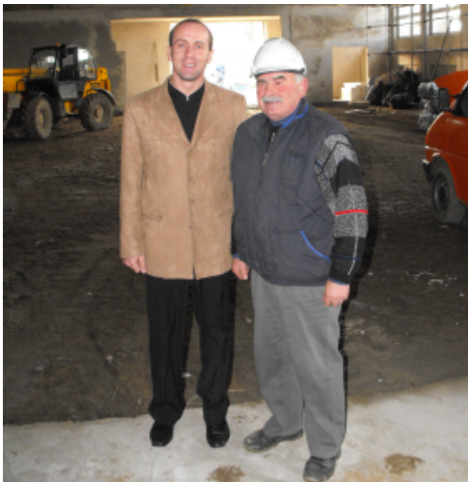
Dyrektor szkoły w Świniarsku na placu budowy sali gimnastycznej.
