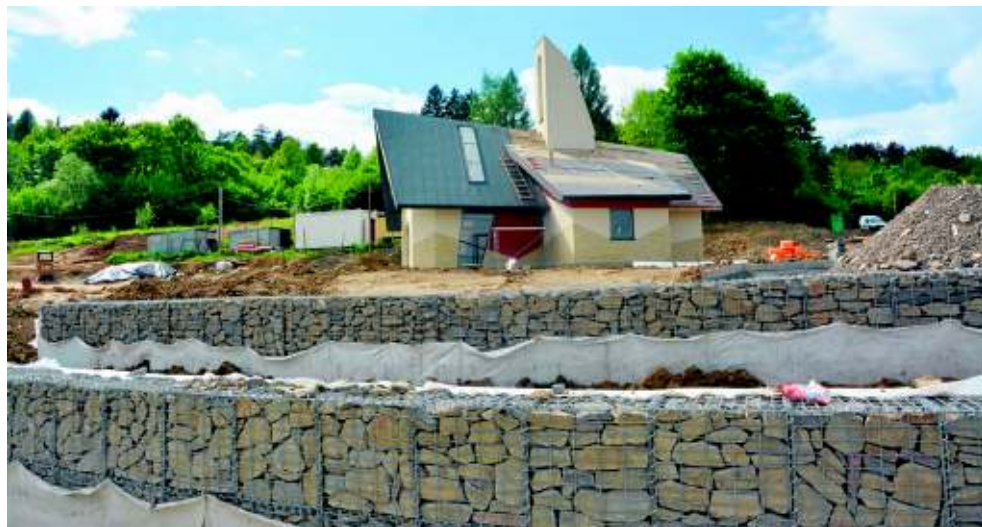
Kaplica cmentarna już stoi – trwają prace wykończeniowe
