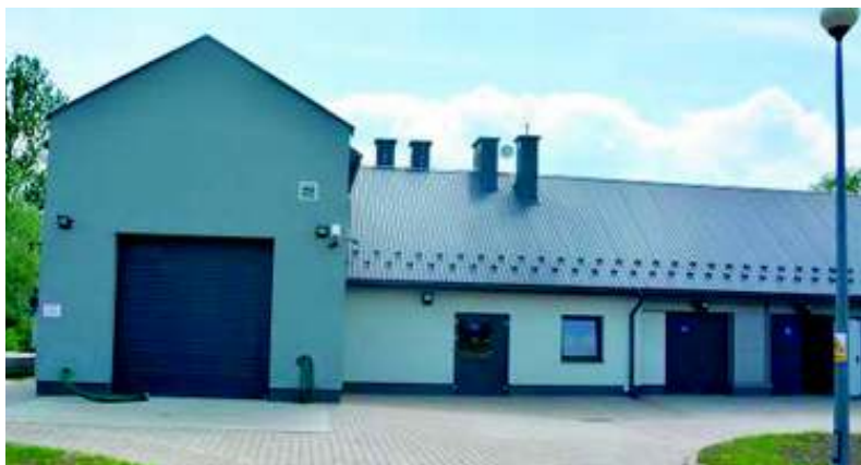
Oczyszczalnia ścieków Mała Wieś
