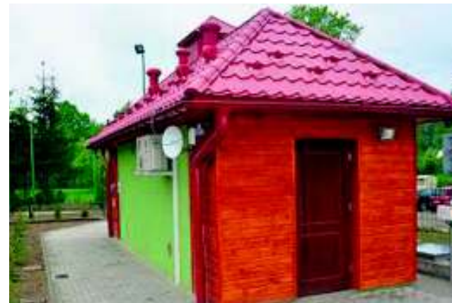
Oczyszczalnia ścieków Piątkowa
