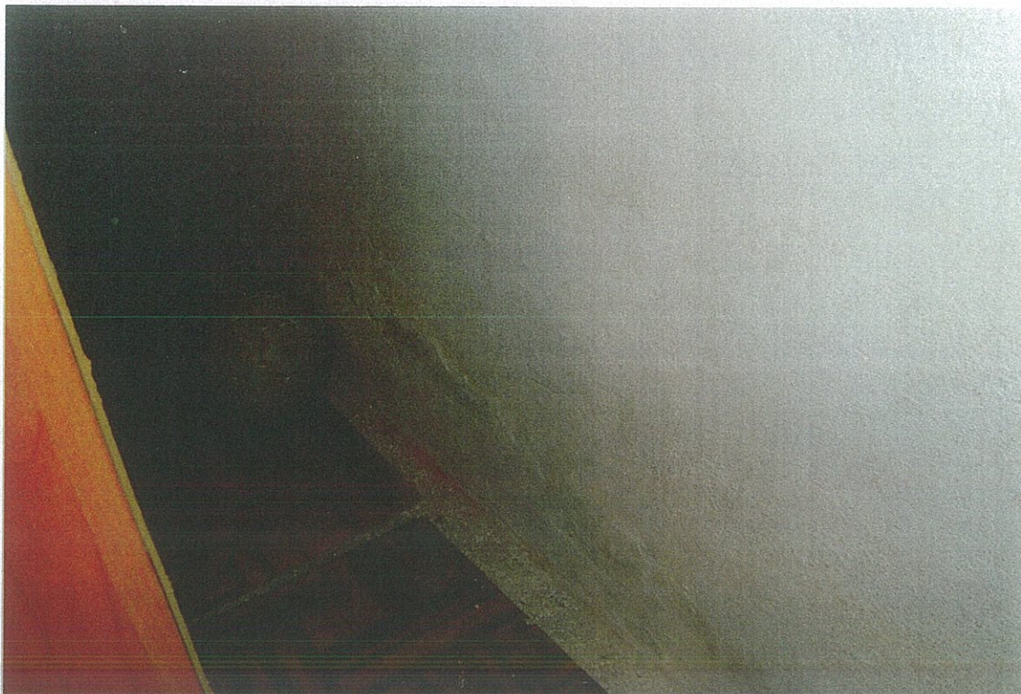
Zawilgocenie ściany poprzecznej w szatni przy Sali tenisa stołowego
