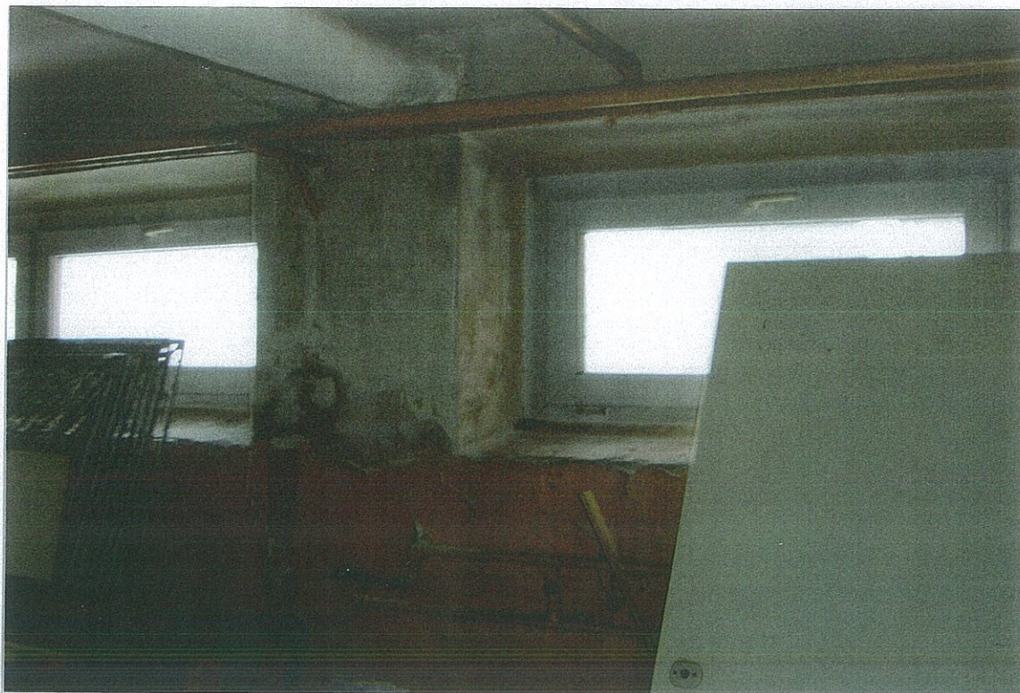
Zawilgocenie ścian w magazynie w części zachodniej budynku
