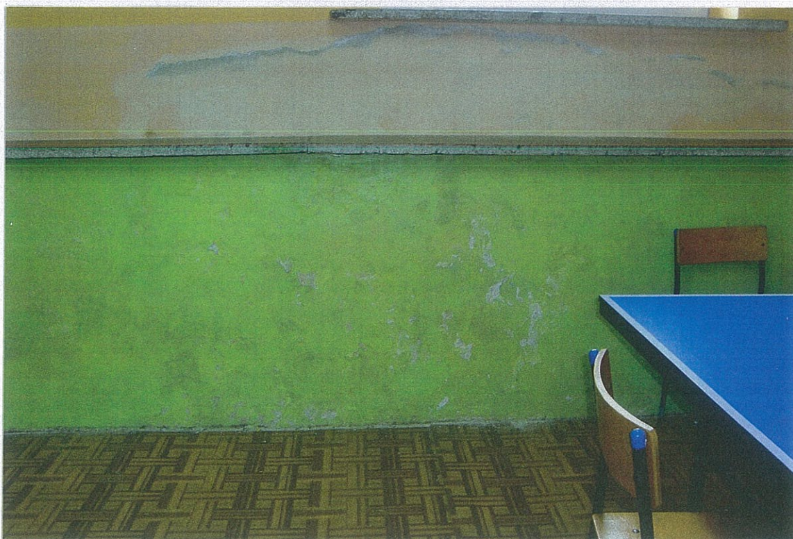
Wilgoć na ścianie podokiennej w Sali tenisa stołowego
