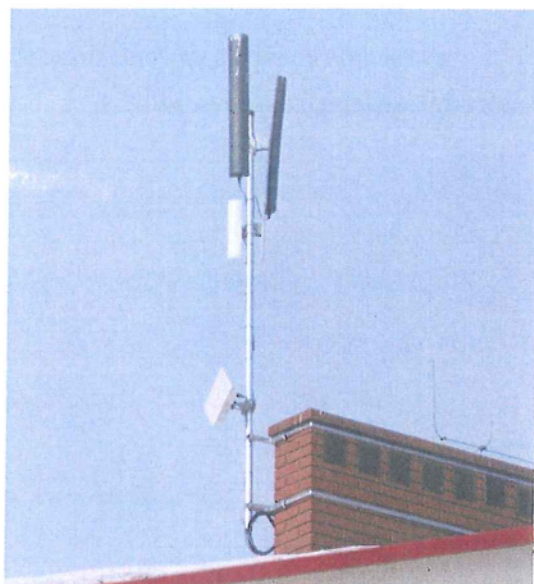
Przykładowa instalacja z wykorzystaniem obejmy kominowej
