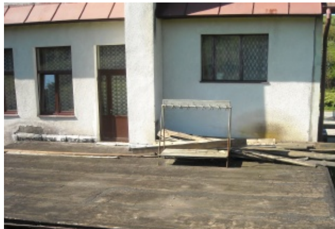
Remiza przed remontem.
