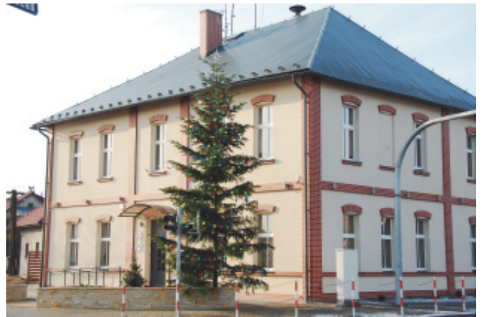
Urząd Gminy po remoncie.
