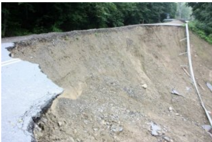
Droga przed remontem.
