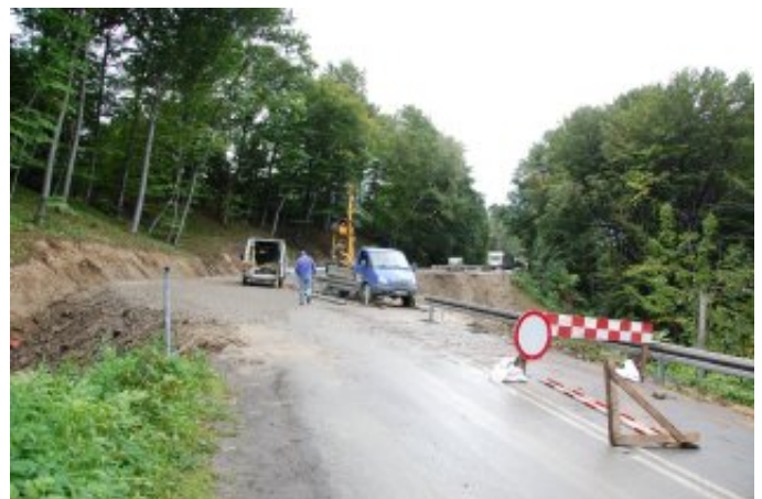
Droga po wykonaniu przejazdu technicznego.
