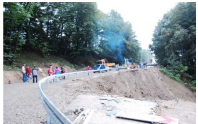
Odbudowa drogi na Woli Kurowskiej..
